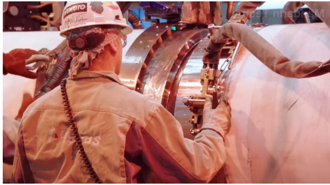
Fortuna lasser plaatst de las volautomaat
